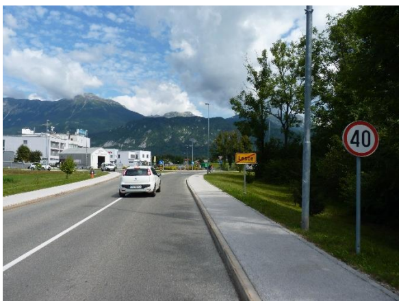
Slika 15: Nesmiselna postavitev prometnega znaka za hitrostno omejitev. Prometni znak bi moral biti postavljen za tablo, ki označuje konec naselja.
