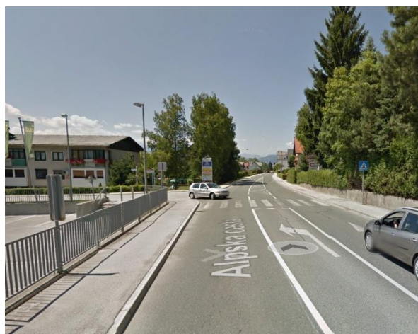
Slika 32: Nevarno umeščen prehod za pešce na Alpski cesti v Lescah (vir: Google)
