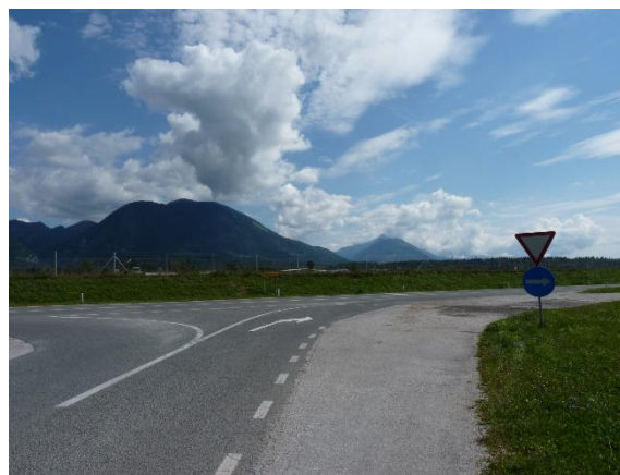
Slika 9: Ob robu vozišča se pojavi makadamska pot, ki se nato nadaljuje z vzporedno cesto. Zaradi dveh različnih vozni površin lahko pride do zdrsa vozila pri zavijanju desno na glavno cesto iz Letališke ulice
