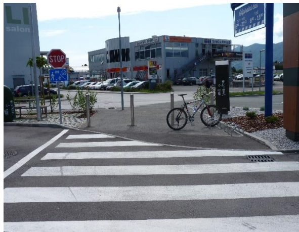
Slika 36: Ustrezno izvedena klančina ob prehodu za pešce v Lescah, ki pa je deloma blokiran s parkiriščem za kolesa
