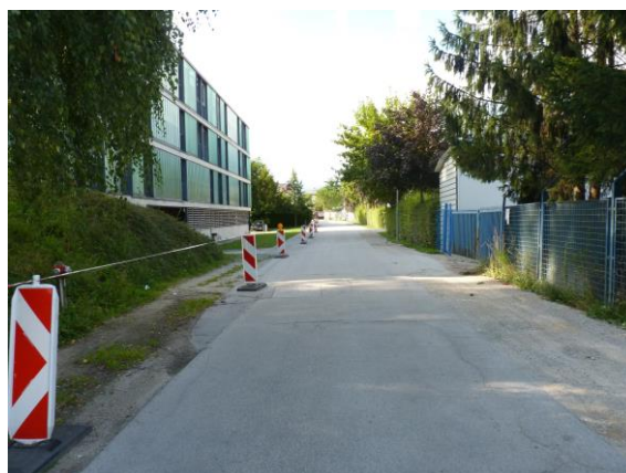
Slika 24: Začasna ograditev roba cestišča z namenom preprečevanja parkiranja
