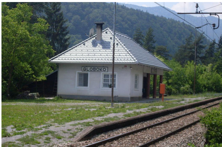
Slika 66: Postajno poslopje železniškega postajališča Globoko
