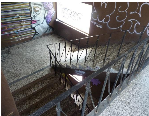
Slika 37: Stopnišče, ki vodi do Železniške postaje Radovljica je brez ustrezne alternative za gibalno ovirane
