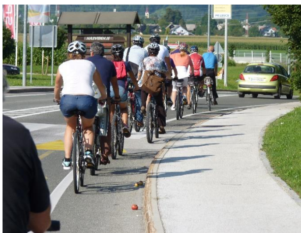
Slika 46: Kolesarska steza na urejena na delu vozišča Kranjske ceste v Radovljici proti Begunjam
