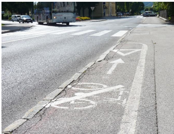
Slika 56: Kolesarska steza se takole konča na cesti, prometna površina pa tudi ni v najboljšem stanju
