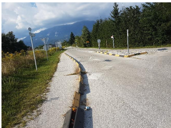
Slika 8: Razpadajoč montažni robnik v krožišču na Dežmanovi cesti
