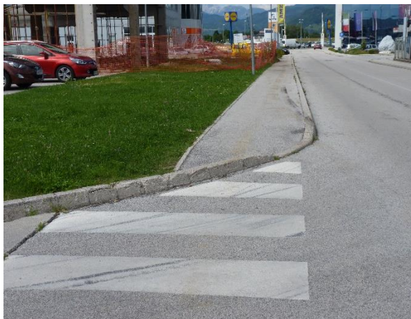
Slika 35: Neustrezna izvedba znižanega robnika oz. klančine v Lescah
